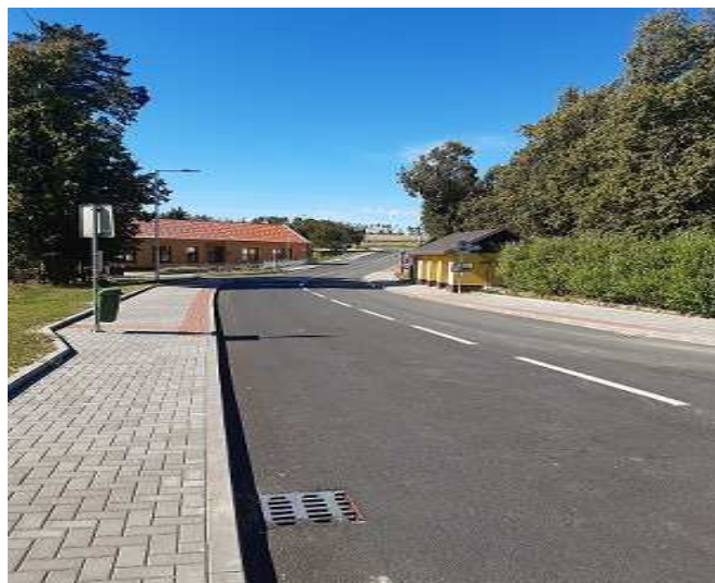
Stav po rekonstrukci
