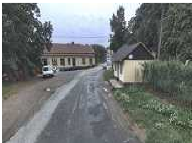
Stav před rekonstrukcí
