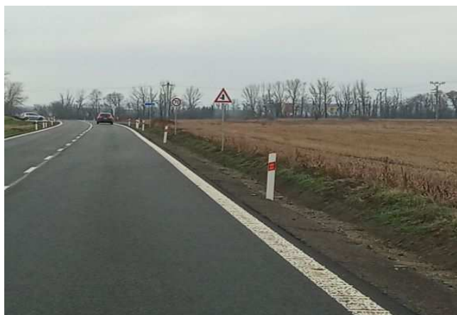
Stav po rekonstrukci SO 105 úsek silnice v k.ú. Ladná
