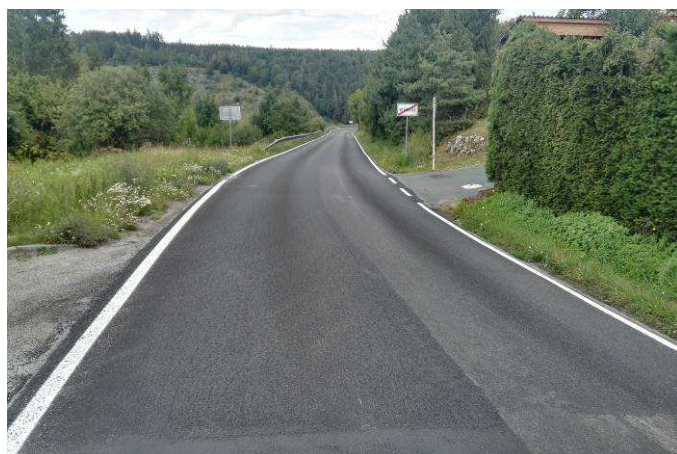
Stav po rekonstrukci
