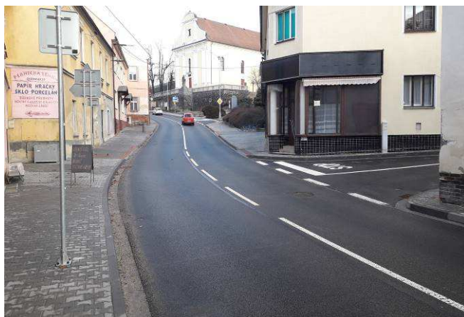
Stav po rekonstrukci
