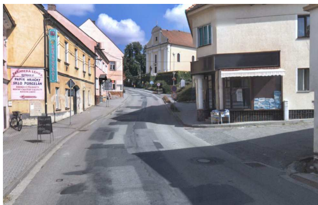
Stav před rekonstrukcí
