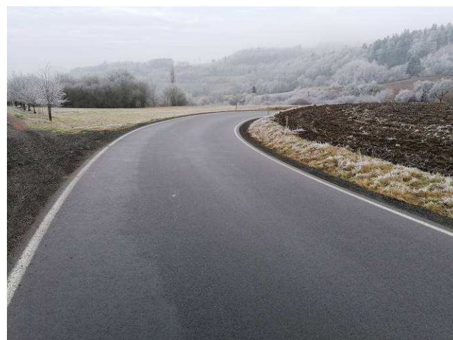
Stav po rekonstrukci
