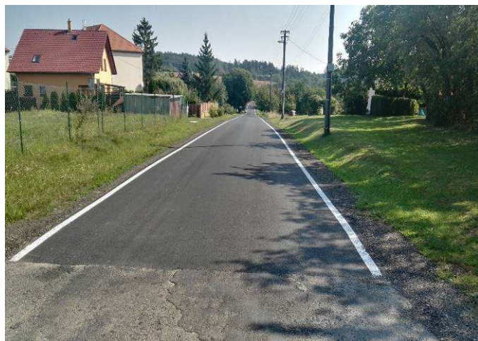
Stav po rekonstrukci
