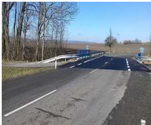
Stav po rekonstrukci
