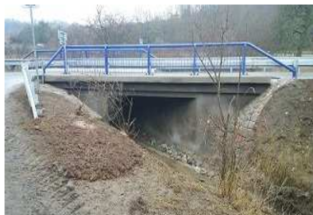
Stav po rekonstrukci
