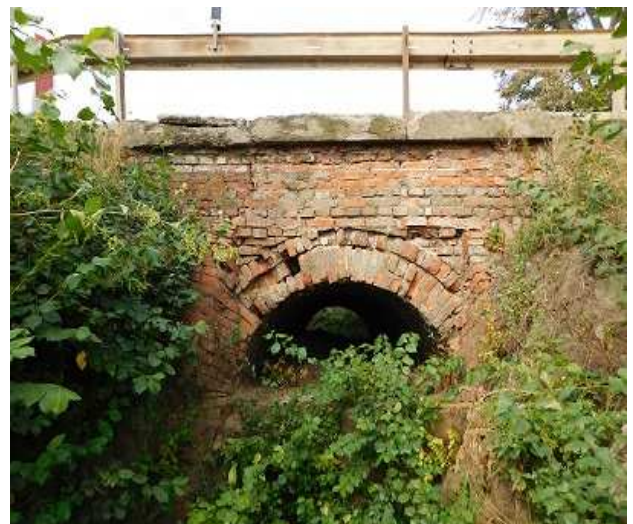
Stav před rekonstrukcí
