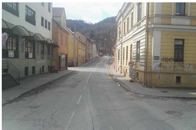
Stav před rekonstrukcí
