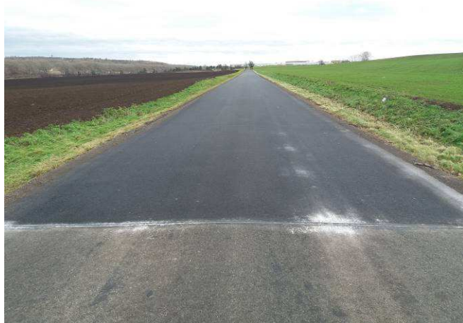
Stav po opravě
