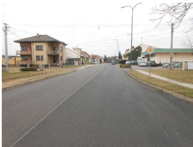
Stav po opravě
