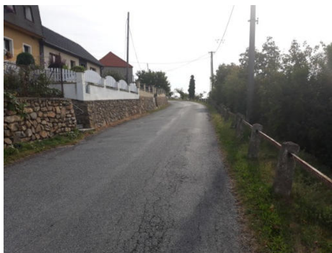
Stav před rekonstrukcí
