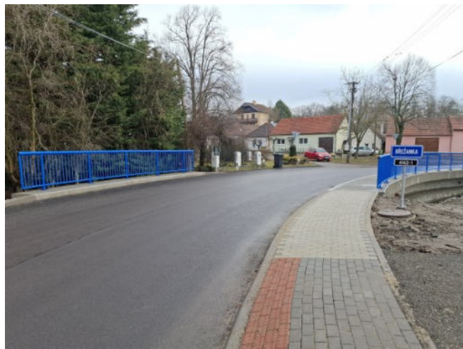
Stav po rekonstrukci
