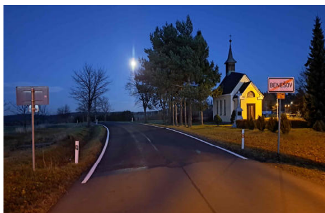
Stav po opravě
