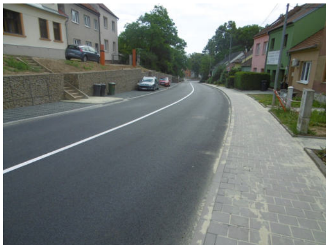
Stav po opravě
