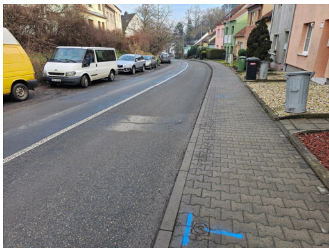
Stav před opravou
