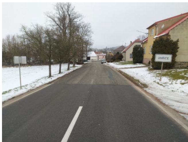
Stav před opravou
