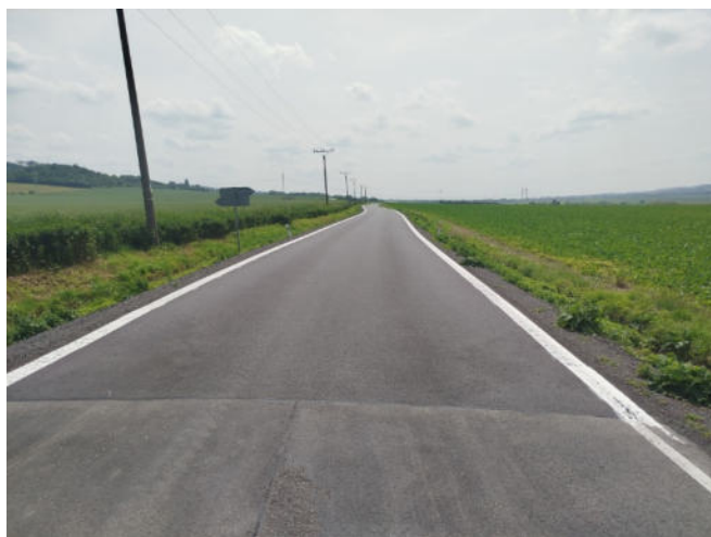
Stav po opravě
